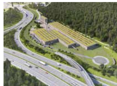
Le Centre de Remisage et de Maintenance.
